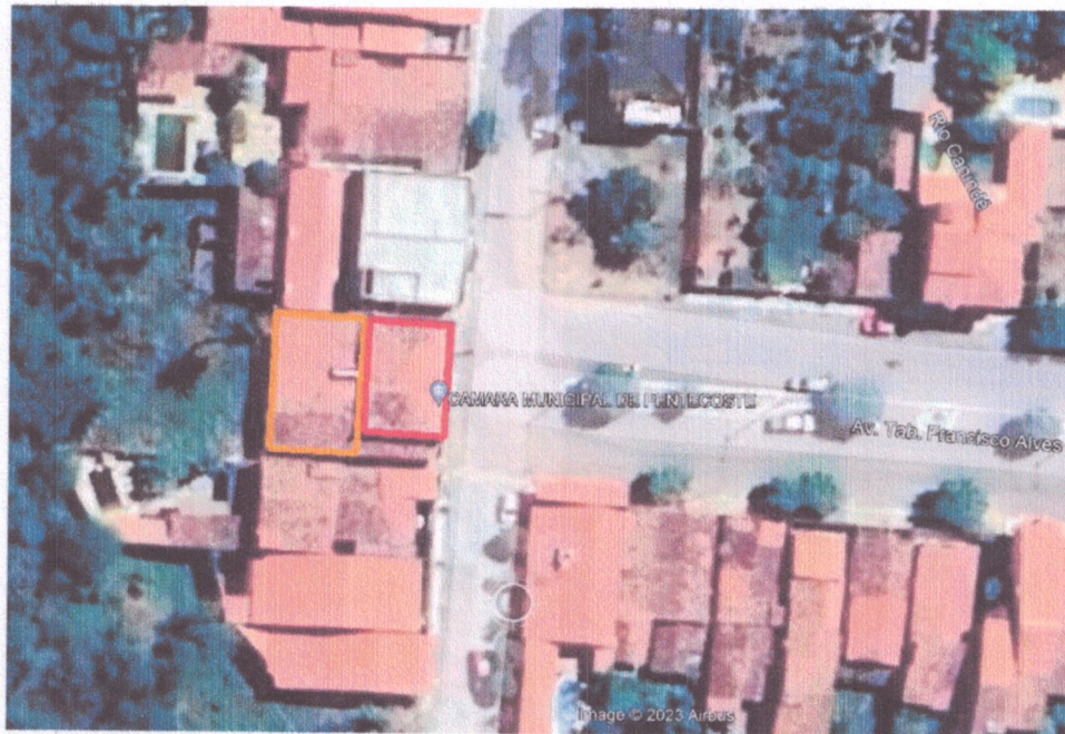
Figura 1 - Identificação da cobertura do edifício via imagem de satélite.
